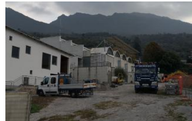
Sono iniziati a Sale Marasino i lavori di restyling dell'area attorno alla scuola
